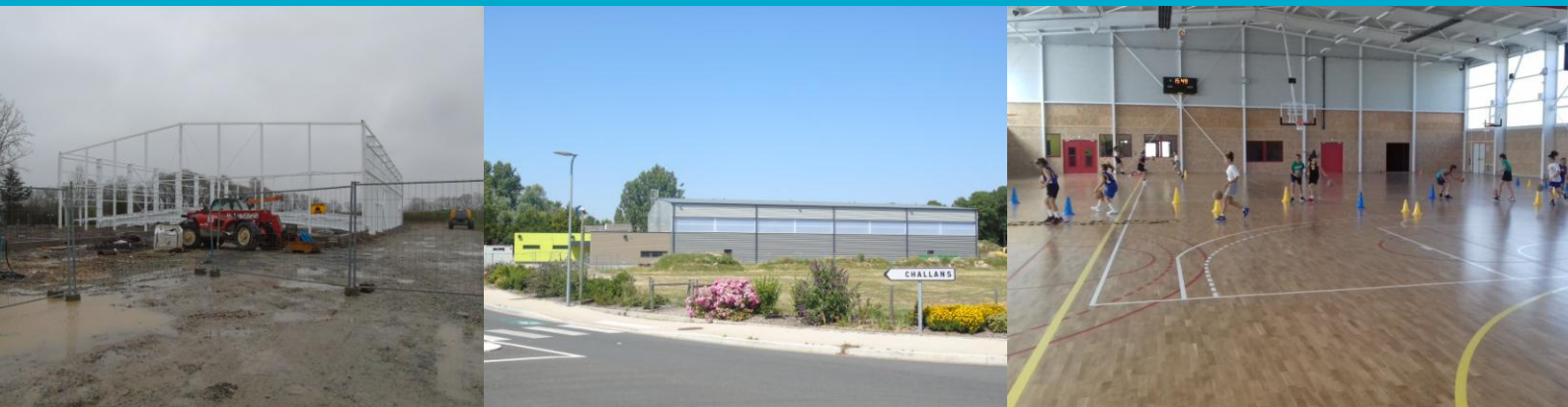
Photos ci-dessus : La construction de la salle de sports de Sallertaine a été réalisée en 2018
