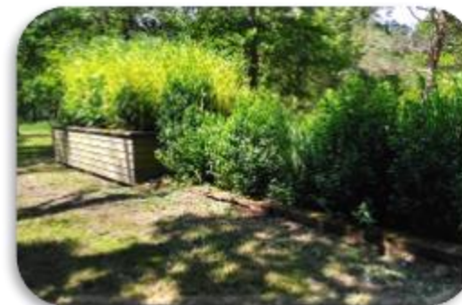
Filtre planté de roseaux
