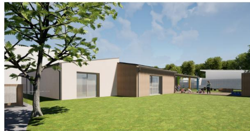
VUE SUR L'ARRIERE DEPUIS LA VOIRIE
